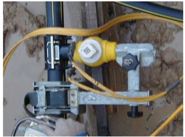
Positionneur de branchement POB 200, monté
