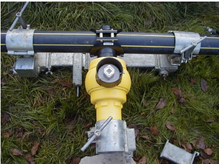
Utilisation du positionneur ARIAS PR 125 pour le soudage de la selle du RPC : pour 110/110, 125/110, 125/125.
