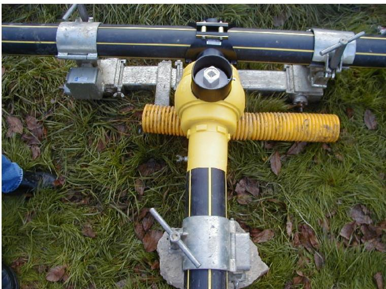
Utilisation du positionneur ARIAS PR 125 pour le raccordement de la dérivation sur le RPC : pour 110/110, 125/110, 125/125.
